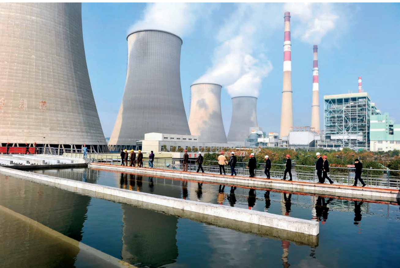
浙能长兴电厂再生水池
