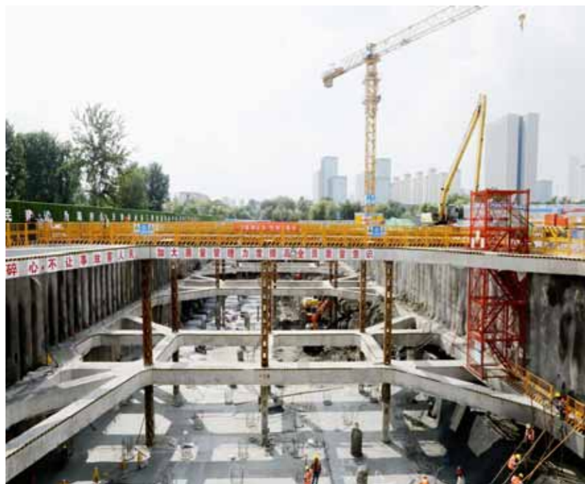
陈塘泵站建设现场
