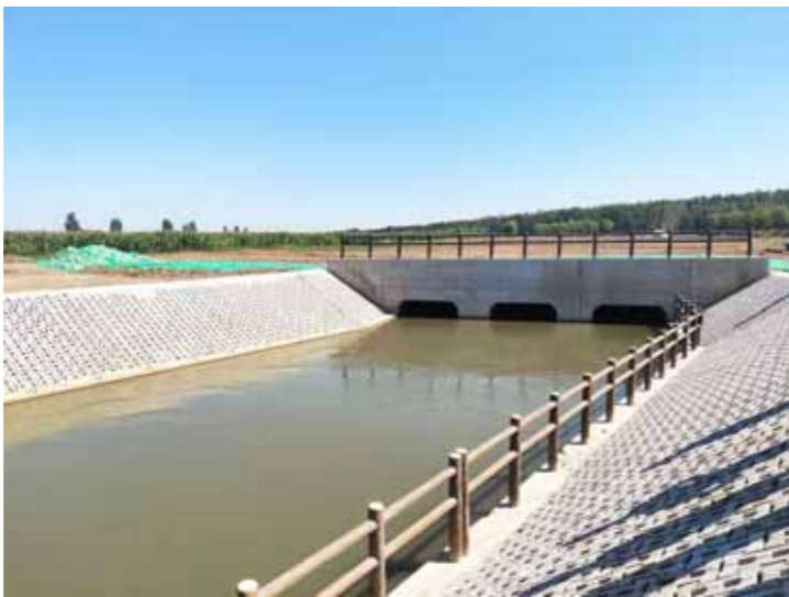
北水南调中线完善工程通水运行
