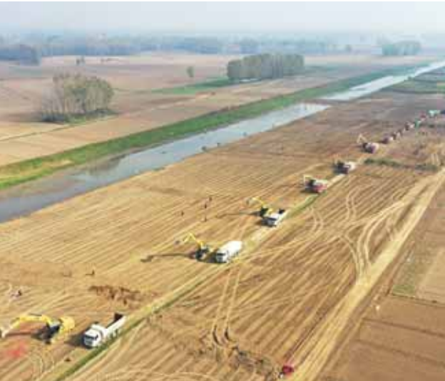
淮河分洪道拓流工程开工建设现场
