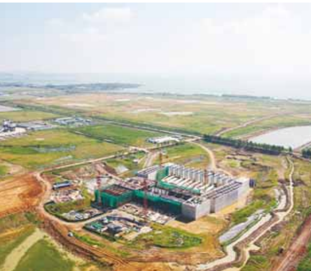
建设中的引江济淮淮河入江口泵站
