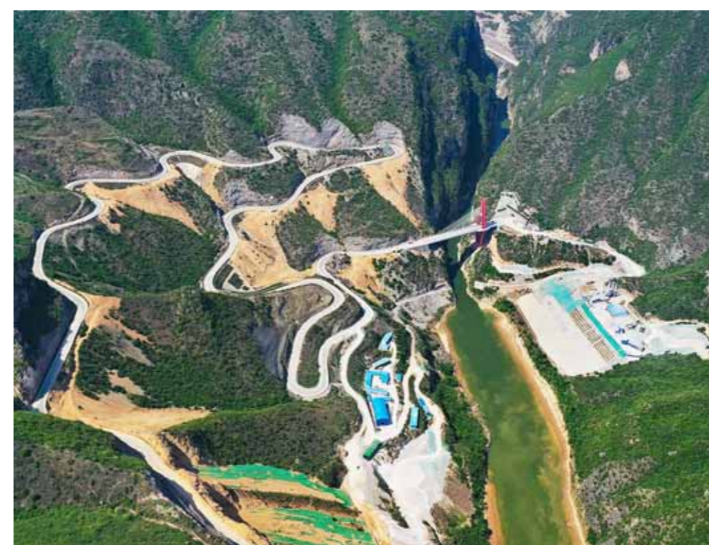
建设中的东庄水利枢纽工程工地 李军朝 摄
