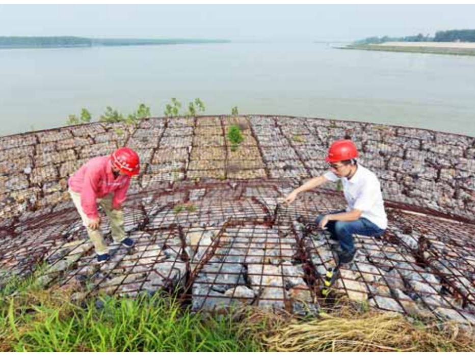
湖北省碾盘山水利水电枢纽工程技术人员在围堰大堤上查险 李广彦 摄
