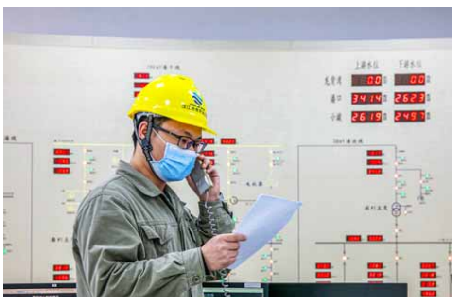
疫情期间坚守一线的湖北潘口水电站工人 王国忠 摄
