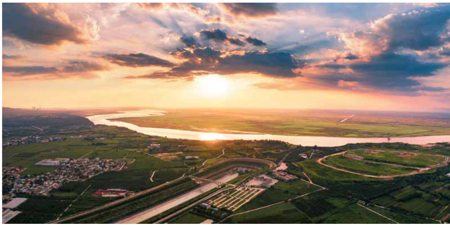
南水北调中线穿黄工程鸟瞰
