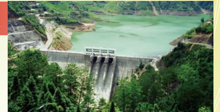
福建省德化县涌溪三级电站
