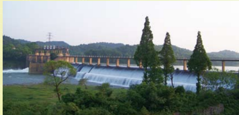
韶山灌区引水枢纽——洋潭大坝
