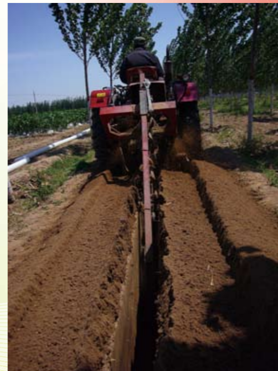
河北利用开沟机铺设低压管道
