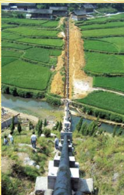
贵州省丹寨县小农水重点县建设场景
