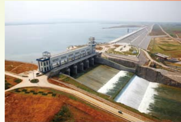
治淮骨干工程河南燕山水库
