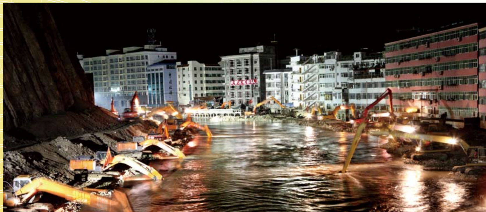
舟曲白龙江淤堵疏通施工现场 李光明 摄
