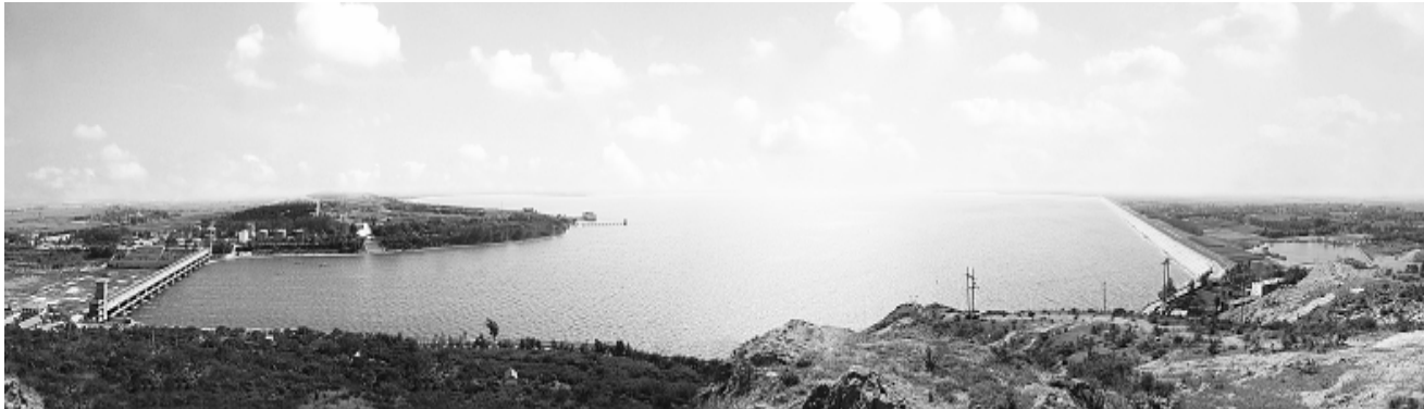
2010年验收完成除险加固工程的峡山水库
