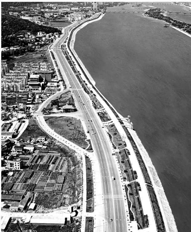
长沙市湘江城市防洪堤鸟瞰
